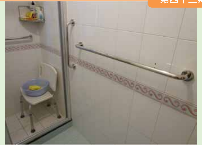
於浴室內安裝適當的扶手，使用洗澡椅坐著洗澡，洗澡時更加安全
